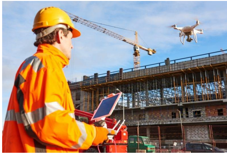
Un operario realizando análisis de obra con un dron.
