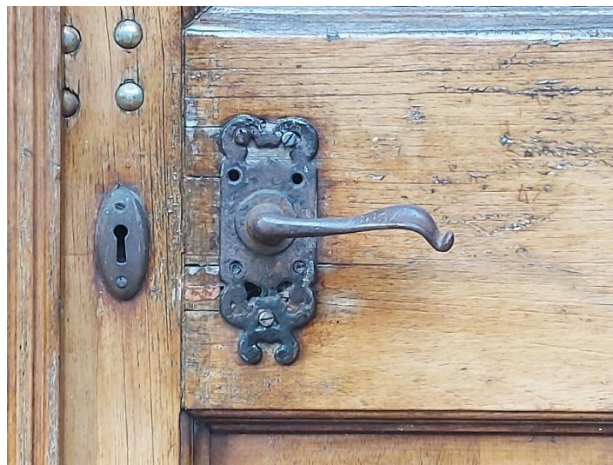
Detalles de la puerta de acceso y su remate escalonado; y el bello picaporte de líneas Art Nouveau. Fotos MF, 2022.
