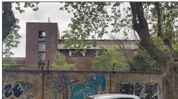
Galpón de la fábrica. Hoy en estado de abandono.
