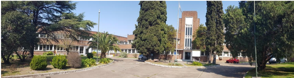
Estado actual del conjunto de edificios hacia Av. Fleming. 2022.
