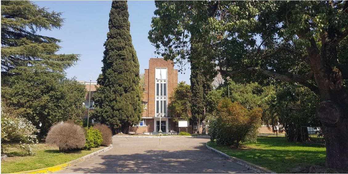
Estado actual de la fachada del Edificio Administrativo. 2022.
