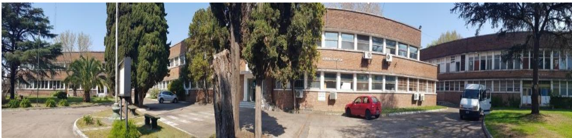
Estado actual del conjunto de edificios hacia Av. Fleming. 2022
