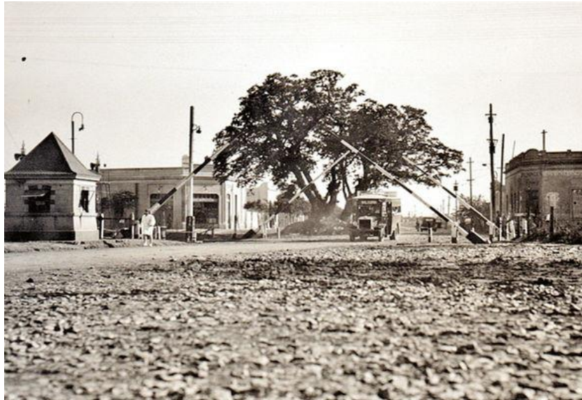
Estación Boulogne, paso a nivel en Av. Rolón y Lebensohn, de este a oeste, y su tradicional ombú.
