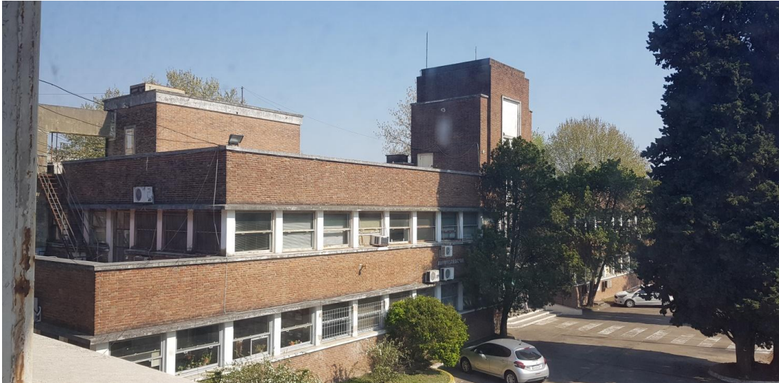
Estado actual del Edificio Administrativo. 2022.
