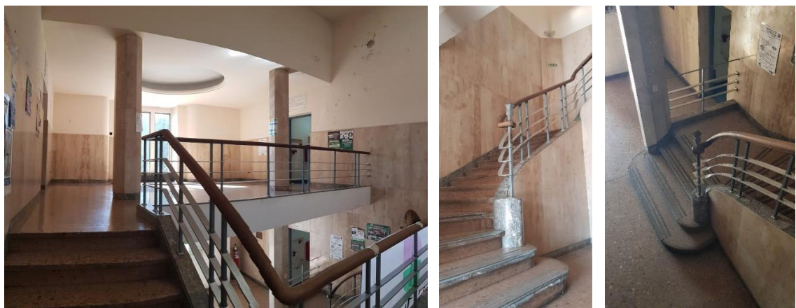
Estado actual del Edificio Administrativo. Espacio central interior, 2022.
