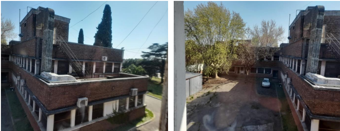
Estado actual del exterior del Edificio Administrativo, 2022.
