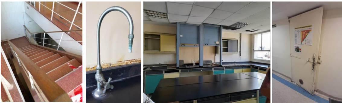
Edificio de laboratorios, escalera al subsuelo - Grifería de laboratorio - Laboratorio, sector de extracción de gases – Puerta cámara de frío.
