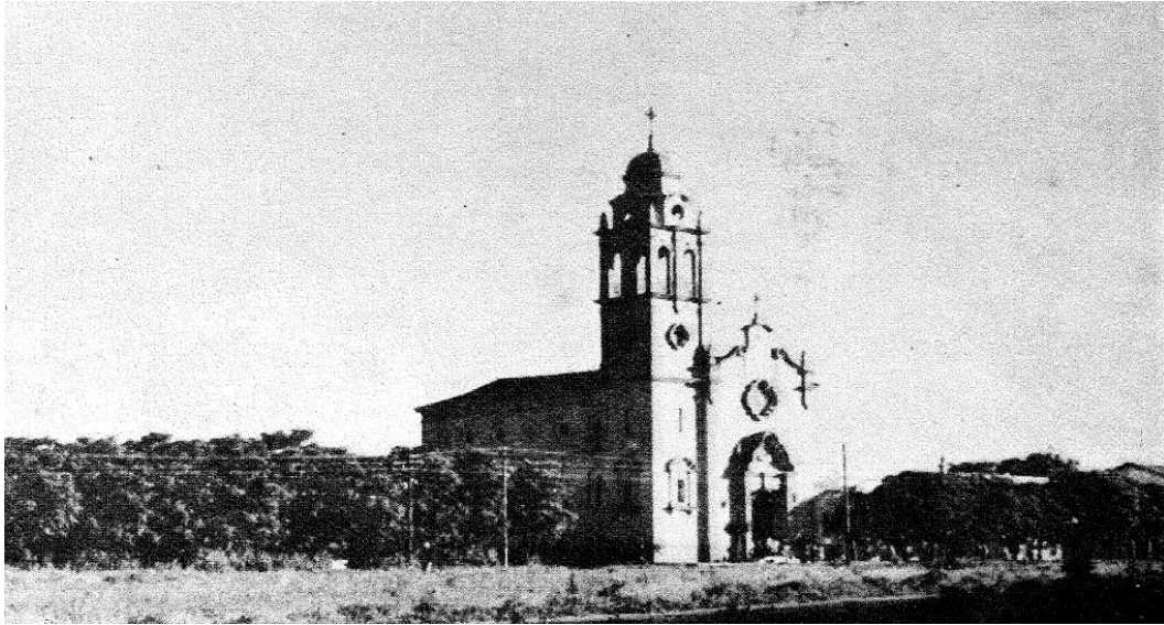
Av. Sucre y Darragueira, Iglesia Santa Rita (1951).
