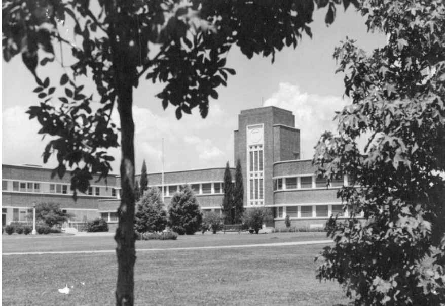
Vista del frente del edificio administrativo y parque de los Laboratorios Farmacéuticos Squibb and Son Argentina S. A. AGN.1956.
