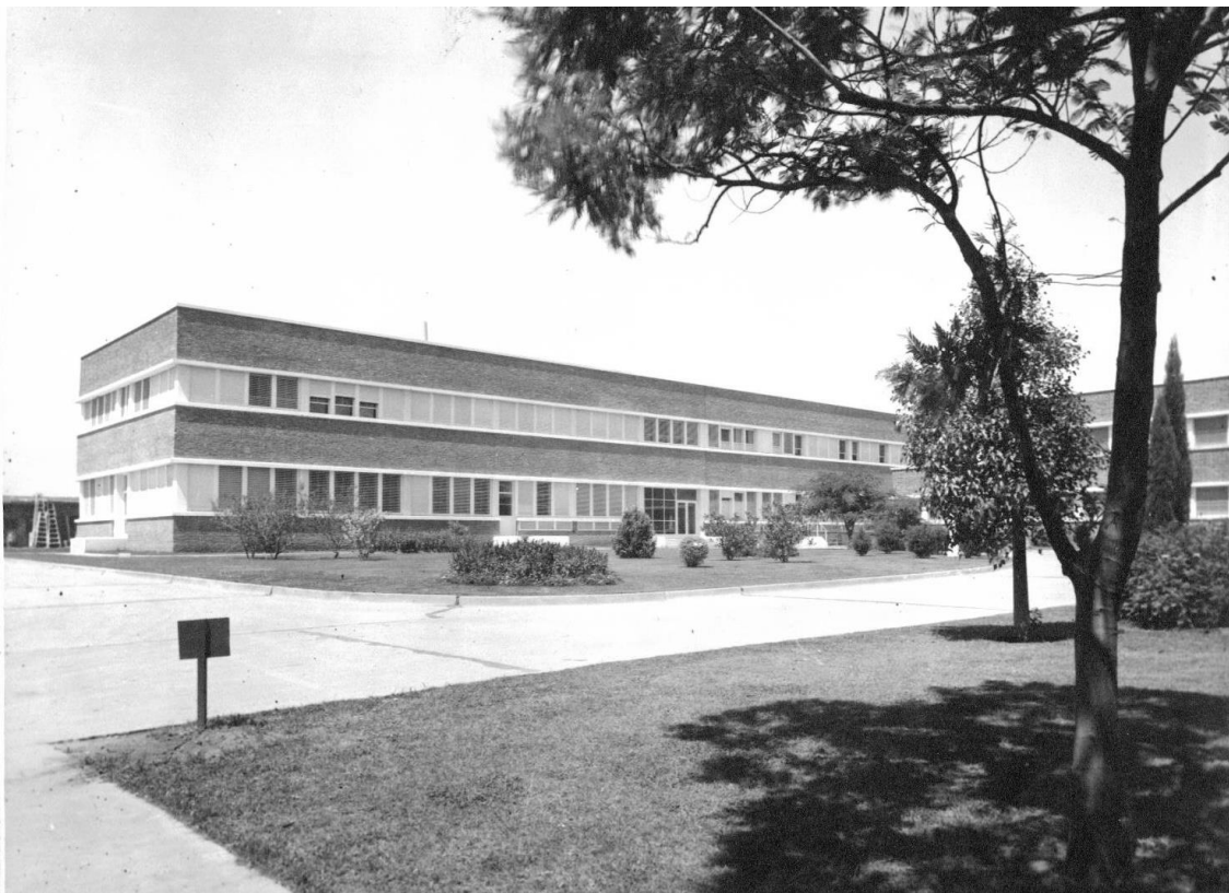
Vista del Edificio Administrativo de los Laboratorios de Investigación. AGN.1956.
