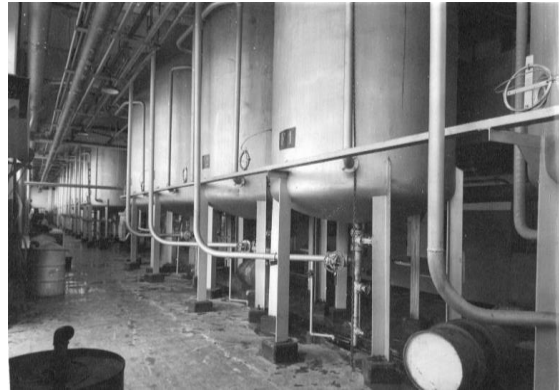
Izq. Vista parcial de la línea de tanques productores de penicilina. Der. Vista parcial de la línea de tanques productores de penicilina. AGN.1956.
