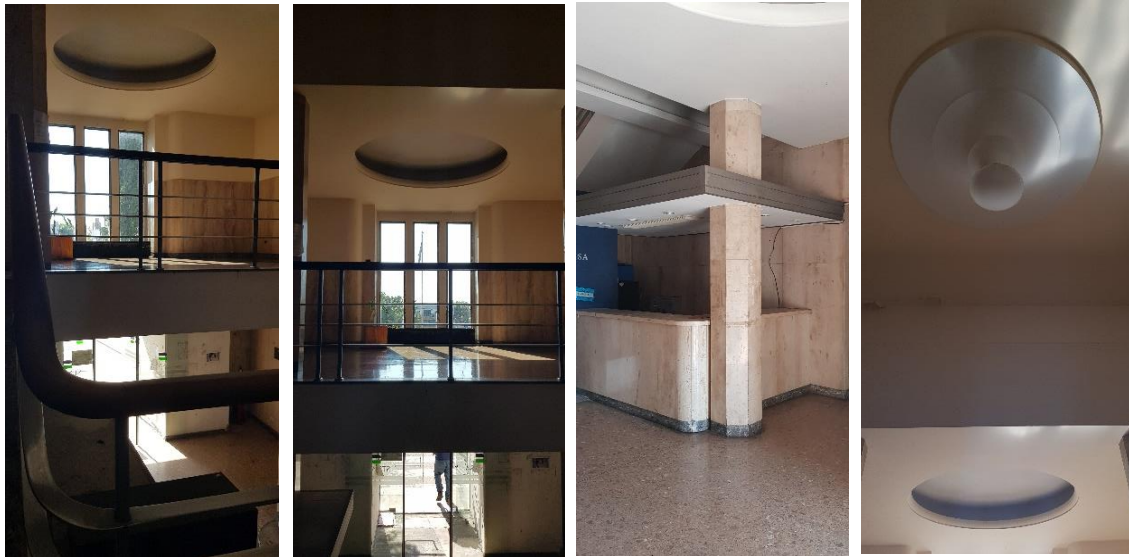
Estado actual del edificio Administrativo. Espacio central interior –Recepción – Luminaria – 2022.
