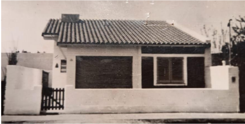
Vivienda terminada a fines de 1954.
