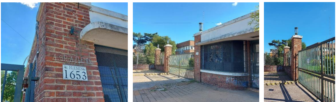
Estado actual del conjunto de edificios hacia Av. Fleming. 2022.
