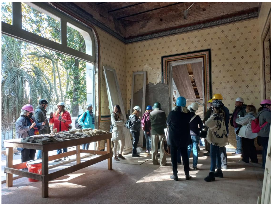
La recuperación de cada detalle del espacio original revestido de azulejos.
