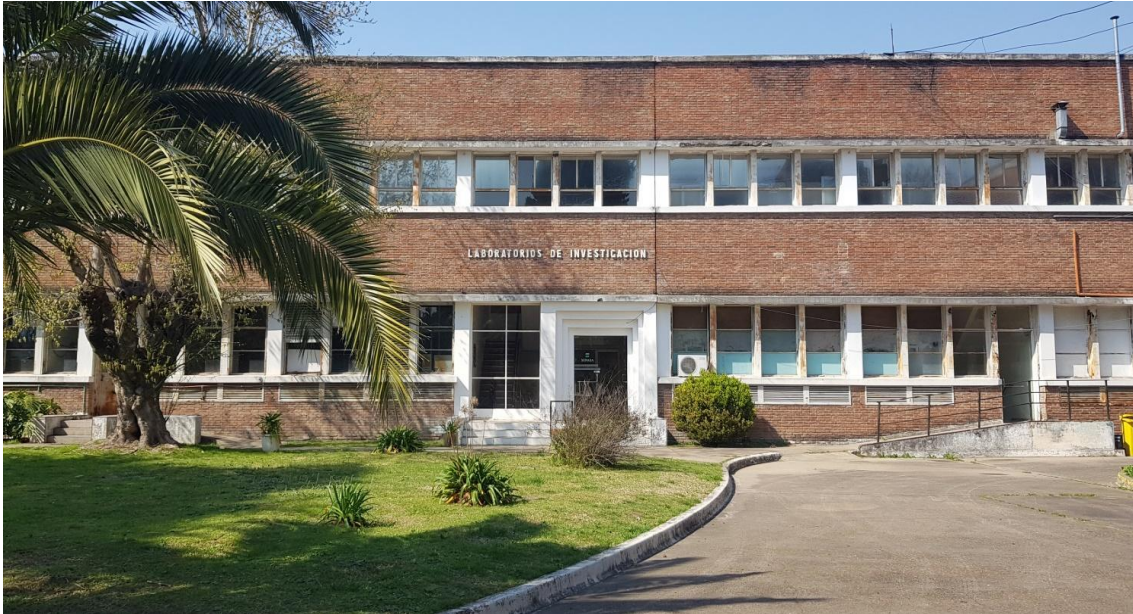
Estado actual de la fachada del Edificio de Laboratorios.
