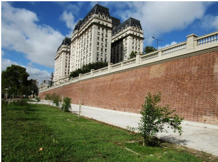
Muro histórico. Fines S XIX.
