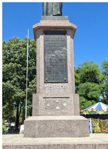
Detalle posterior y frontal del pedestal, donde se observa que dos placas han sido removidas.
