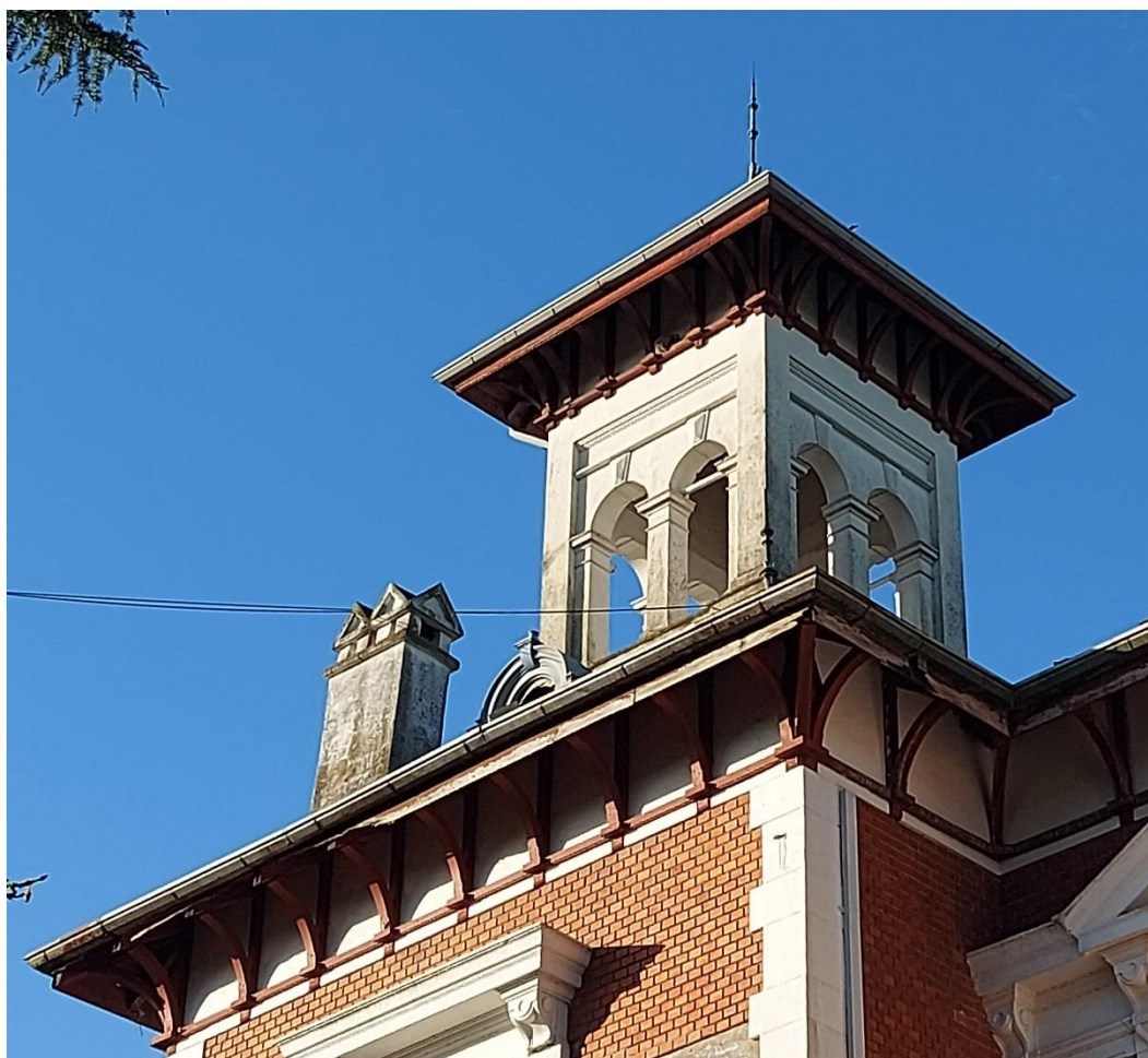
La sucesión rítmica de las ménsulas de madera por debajo del saledizo del techo (Foto OADM, 2021).
