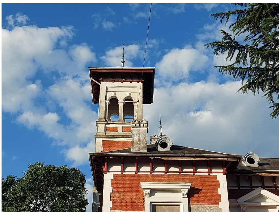
Una vista del mirador o belvedere que sobresale por encima del volumen superior del edificio. (Foto OADM, 2021).
