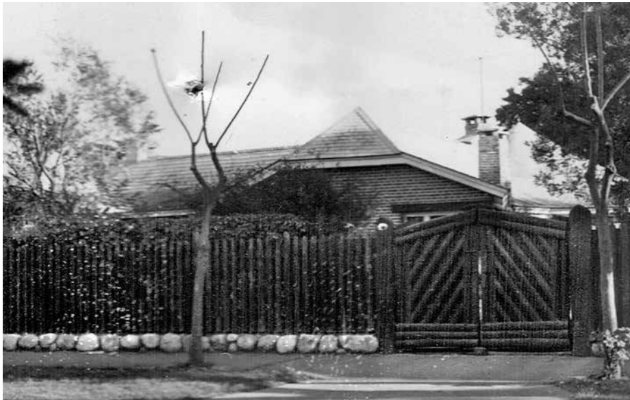
La Casa Isler registrada en imágenes para el expediente municipal. Se observan los troncos y el techo ya modificados. MSI-ATM. Expediente 8952-I-1948. Jacobo Isler/Ampliación.
