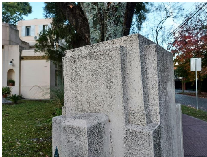
Las bandas verticales superpuestas (marca formal art déco), en uno de los pilares bajos del acceso (Foto OADM, 2022).
