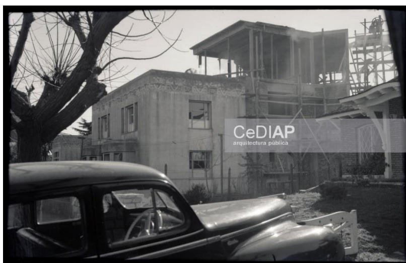
La obra de ampliación del edificio en registros fotográficos oficiales de época (MOP 2384-00027_C y 2384-00026_C, CeDIAP).
